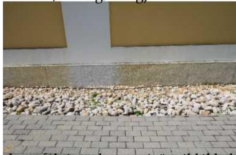
Lábazat: Stokkolt, táblás osztású műkőlabazat. (Horváth István, Zalaegerszeg)
